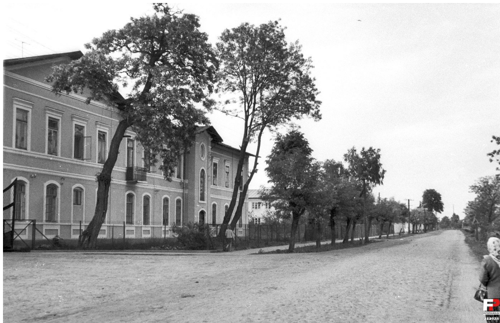
Budynek przedwojennej cukrowni 'Czersk' w Jasieńcu (1949-1959). Zakład, założony w XIX wieku, odegrał kluczową rolę w rozwoju lokalnej gospodarki i przemysłu.
